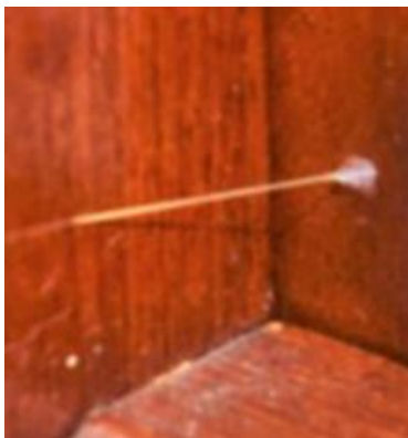
HILO DE SILICONA Se rompe al abrir la puerta
